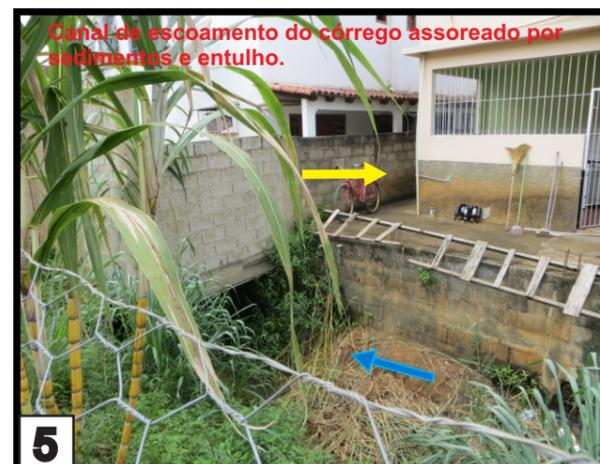
Canal de escoamento do córrego assoreado por sedimentos e entulho.
