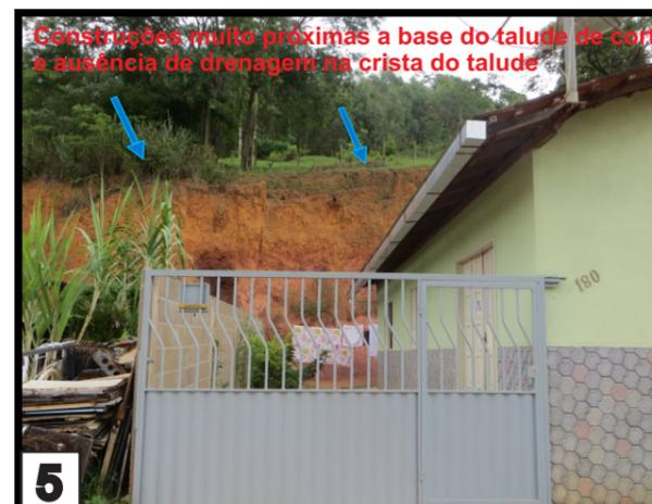
**Descrição:** Encosta com média declividade e altura aproximada de 30 metros. A base está ocupada por moradias de alvenaria. Inúmeros cortes verticais na base da encosta com as construções muito próximas a base ou topo do talude de corte. Não existe um sistema de drenagem de águas pluviais na base ou crista dos taludes. Sinais de movimentação de sedimentos com a presença de ravinas em alguns trechos.
