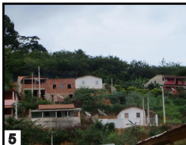
**Descrição:** Encosta de declividade elevada e altura média, ocupada por casas de baixo e médio padrão em alvenaria (**figura 5**). Alguns cortes a 90° em relação à encosta (**figura 3**) e residências próximas à beirada da encosta (**figuras 1 e 4**). Ausência de drenagem para escoamento de águas pluviais e servidas são e de calhas nas casas. Há ocorrência de processos erosivos na rua (**figura 2**).
