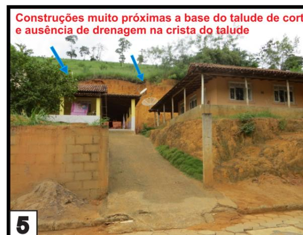
**Descrição:** Encosta com declividade média e altura elevada cuja base está ocupada por moradias de bom padrão construtivo. Inúmeros cortes verticais na base da encosta, alguns de grande altura. Sinais de movimentação de sedimentos a montante dos cortes. Não existe um sistema de drenagem de águas pluviais. Presença de trincas no talude. Ausência de drenagem na crista dos taludes de corte.
